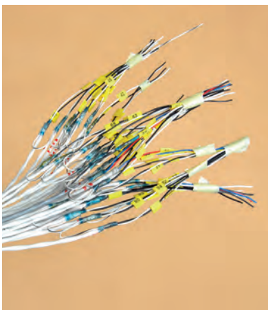
Preparación e identificación de conductores
