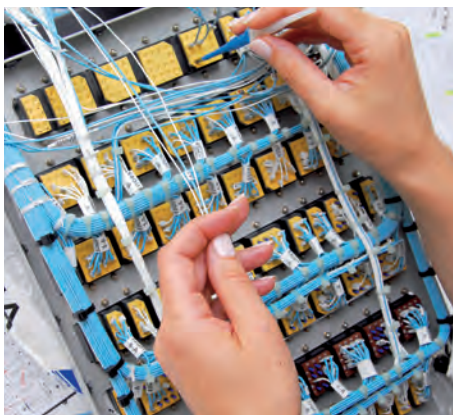
Conexión de cajas de relés
